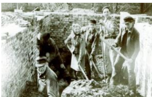
17 Arbeitseinsatz bei der Errichtung des Kulturhauses Plessa (Archiv Pierre Wilhelm)
