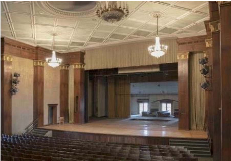
16 typische Bühne in den größeren Kulturhäusern mit Beleuchtungspunkten vor der Bühne, abgedecktem Orchestergraben, großem Portal, Brandschutztor, Hauptbühne mit Prospektzügen und Hubpodium sowie Nebenbühnen (Verein Kulturpalast Unterwellenborn e.V.)
